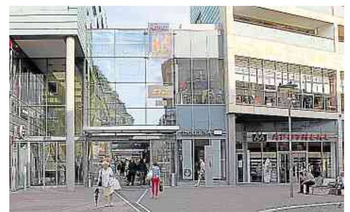
Nicht nur die Kunden bringen derzeit Leben in die Römerpassage. Die Umbauarbeiten für die neuen Geschäfte sind in vollem Gange. Foto: Bernd Eßling
