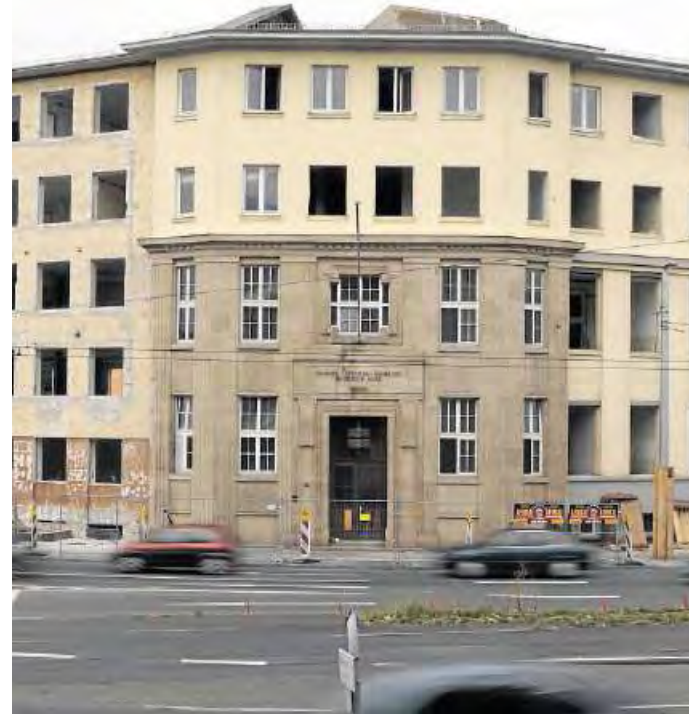
Der Abriss der früheren Musik- und Kunsthochschule am Binger Schlag hat bereits begonnen. Foto: Sascha Kopp
